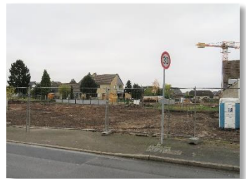
Es tut sich was auf der Baustelle am Töpferweg.
